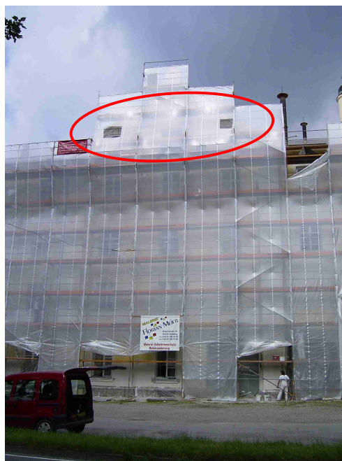
Abb. 4-17: Brauerei in Maxrain (Bayern, D). Die Ausflugsöffnungen der rund 250-köpfigen Wimperfledermauskolonie befinden sich im obersten Dachgeschoß. 2005 wurde die Fassade saniert. Die Verkleidung wurde vor den Ausflugsöffnungen entfernt. Foto: A. Zahn
