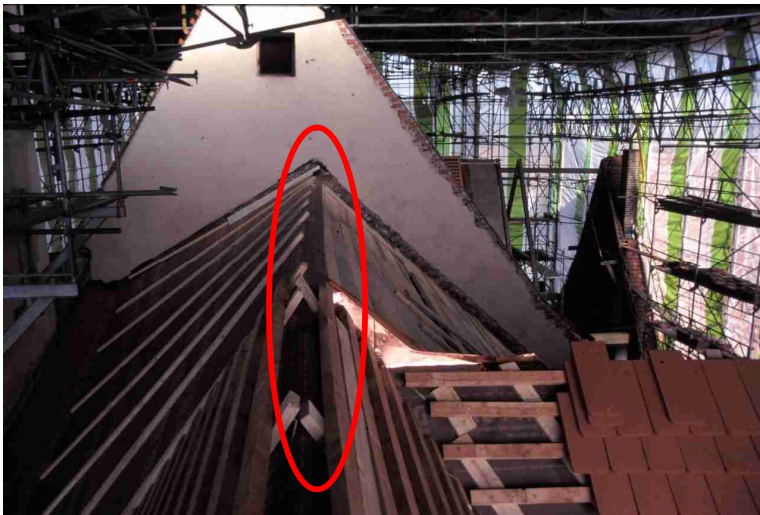
Abb. 4-26: In Beyharting (Bayern, D) wurde im First eine dampfdurchlässige Folie angebracht, die einen gewissen Warmluftstau ermöglicht. Unter der Folie befindet sich eine Verbretterung, an der die Tiere wie vor der Sanierung im Sommer hängen. Bei Kälte (Frühjahr) halten sich die Tiere jedoch wie schon in den Vorjahren in einem angrenzenden, wärmeren Dachstuhl auf. Dazu fliegen sie durch eine Feuerschutzklappe (kleines Bild), die ca. 70 cm unterhalb des früheren Durchschlupfs (Mauerlücke) angebracht wurde. Fotos: A. Zahn
