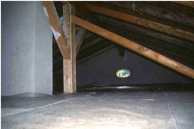
Abb. 4-8: Sanierungsbeispiel Volksschule Wald im Pinzgau (Salzburg, A). Die Wärmedämmung erfolgte am Boden des Dachstuhls anstatt im Dach selbst. Die Dämmplatten wurden mit Folie abgedeckt um den Kot aufzufangen, im Hintergrund ist die runde Ausflugsöffnung sichtbar. Ein Außengerüst wurde von den Tieren akzeptiert. Fotos: M. Jerabek
