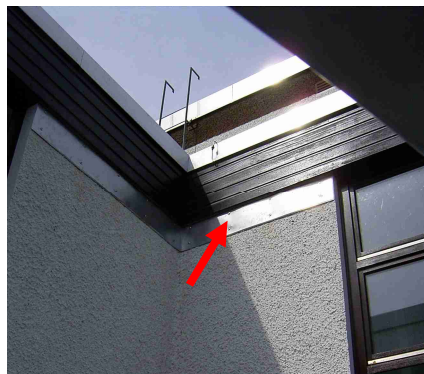
Abb. 4-30: ‚Fledermausabweiser‘ aus Blech zur Verhinderung des Einflugs der Abendsegler über den Hauseingängen (Wasserburg, Bayern, D). Foto: A. Zahn
