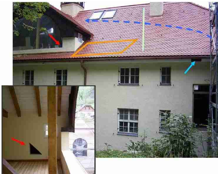
Abb. 4-7: Sanierung Kraftwerks- und Wohngebäude Aschau (Bayern, D). Situation nach dem Umbau 2004 (Ansicht der Gebäuderückseite). Grün: Grenze zwischen dem Wohnbereich (links) und dem Fledermausbereich (rechts). Gestrichelte blaue Linie: Früherer Flugweg zur Ein- und Ausflugsöffnung. Hellblauer Pfeil: Neue Öffnung, die den Tieren aus dem Vorjahr 2003 nicht bekannt war und die nicht genutzt wird. Rote Pfeile (großes und kleines Bild): Zusätzliche Öffnung an der Dachterrasse (hier bestand 2003 eine große Öffnung im Dach), die von den Tieren angenommen wurde. Orange: Toter Raum, der eine Flugwegverbindung zwischen der neuen Öffnung am Balkon und dem Fledermausbereich vorbei am Wohnbereich ermöglicht. Fotos: A. Zahn
