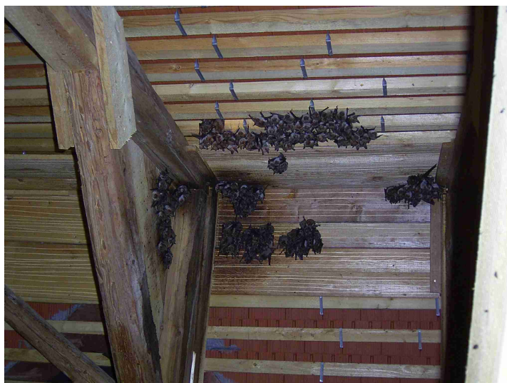
Abb. 4-24: Verbretterung im First in der Kirche Frickkofen (Bayern, D). Durch die spaltenfreien Nut- und Federbretter (im First dicht geschlossen) wird ein Warmluftstau erreicht. Die Tiere hingen bereits im ersten Jahr an den neuen Brettern. Foto: A. Zahn
