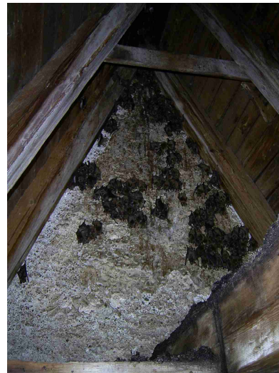
Abb. 4-19: Mausohren am Hangplatz im First (links) und an einem Hitzehangplatz an einer Mauer (rechts). Erkennbar ist die braune Verfärbung der Hangplätze, durch Harnstein hell gefärbte Bretter und im Vordergrund des rechten Bildes Kotablagerungen auf tragenden Balken. Fotos: A. Zahn
